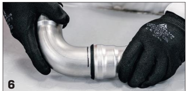
Inserimento tubo nel raccordo / Inserting of the pipe into the fitting
