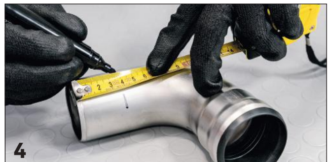
Marcatura quota d'innesto / Marking the insertion's depth
